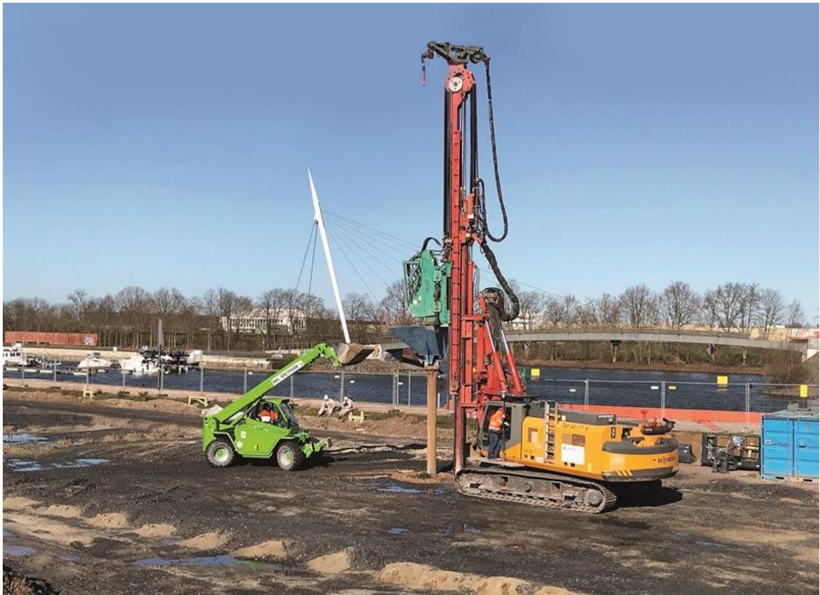
Bild: Ein Merlo Teleskoplader aus dem HKL MIETPARK unterstützt die Firma Geopier Spezialtiefbau GmbH in Gelsenkirchen.
